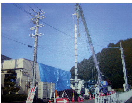
杭打ち作業中
