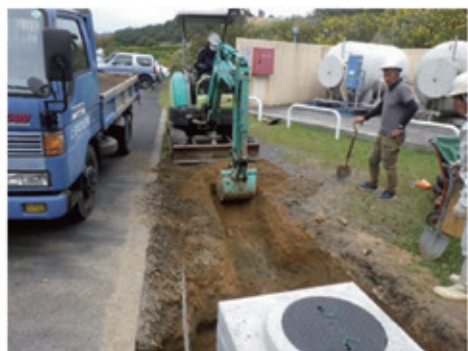
非常用発電機配線埋設
