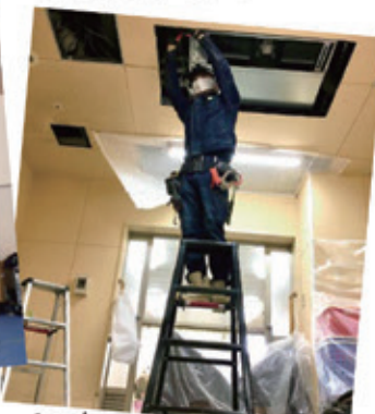
250台の室内機全て入替
