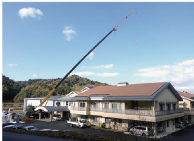
クレーン車で室外機を搬入
